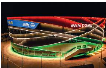
MVM Dome, Budapest - 4 db Hoval UltraGas® D kondenzációs ikerkazán
