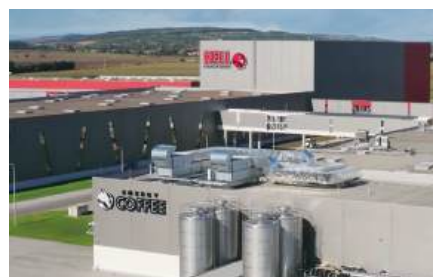
Hell Energy, Szikszó - 67 db Hoval TopVent®, 3 db Hoval HomeVent® RS lakásszellőztető, 4 db Hoval TopGas® gázkazán
