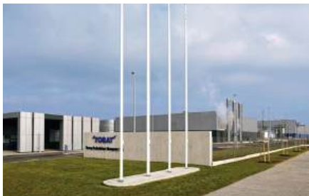
Toray, Nyergesújfalu - 30 db Hoval TopVent®, 2 db Ho- val TopGas® 100
