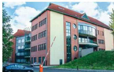
Balassa Kórház, Szekszárd - 4 pcs Magnabosco rapid steam generator, 2 pcs SKI diathermic oil heaters, 43 pcs Hoval UltraGas®
