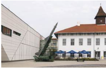
RepTár Repülómúzeum, Szolnok - 8 pcs Hoval TopVent® DGV and CAU units
