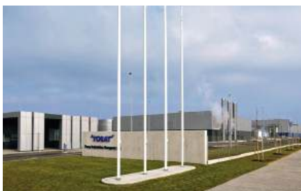
Toray, Nyergesújfalu - 30 pcs Hoval TopVent®, 2 pcs Hoval TopGas® 100
