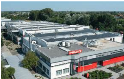
Hilti-gyár, Kecskemét - 33 pcs Hoval TopVent® and 9 pcs RoofVent® RP, 2 pcs ProcessVent®, 7 pcs Enerblue heat pumps
