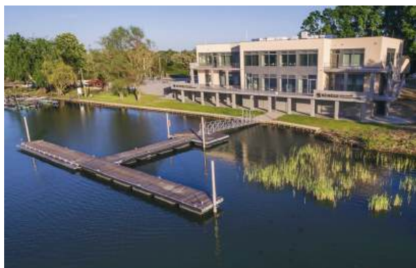
Kérész Központ, Tiszafüred - 2 pcs M-Tec WPS heat pumps, 1 pcs Hoval EnerVal buffer storage
