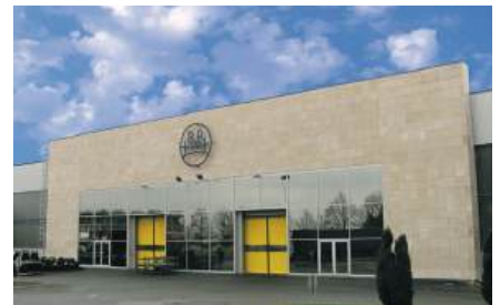
BPW-Hungária Kft., Szombathely - 32 pcs Hoval TopVent®, 21 pcs Hoval RoofVent® units
