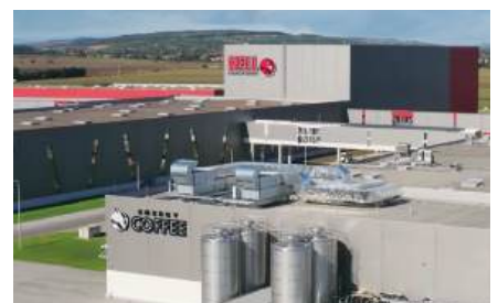
Hell Energy, Szikszó - 67 pcs Hoval TopVent®, 3 pcs Hoval HomeVent® RS ventilation units, 4 pcs Hoval TopGas® gas boiler
