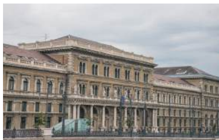
Corvinus Egyetem, Budapest - 16 pcs Hoval UltraGas® gas condensing boilers
